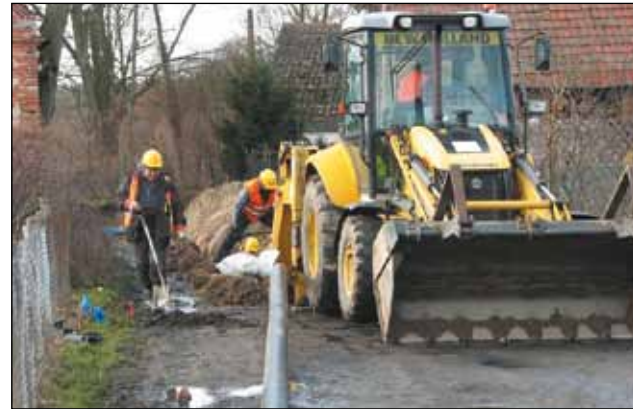
Prace podczas budowy wodociągu w m. Kozów
